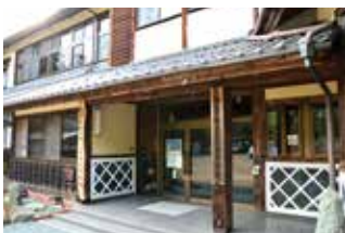
木造建築の正面入り口
