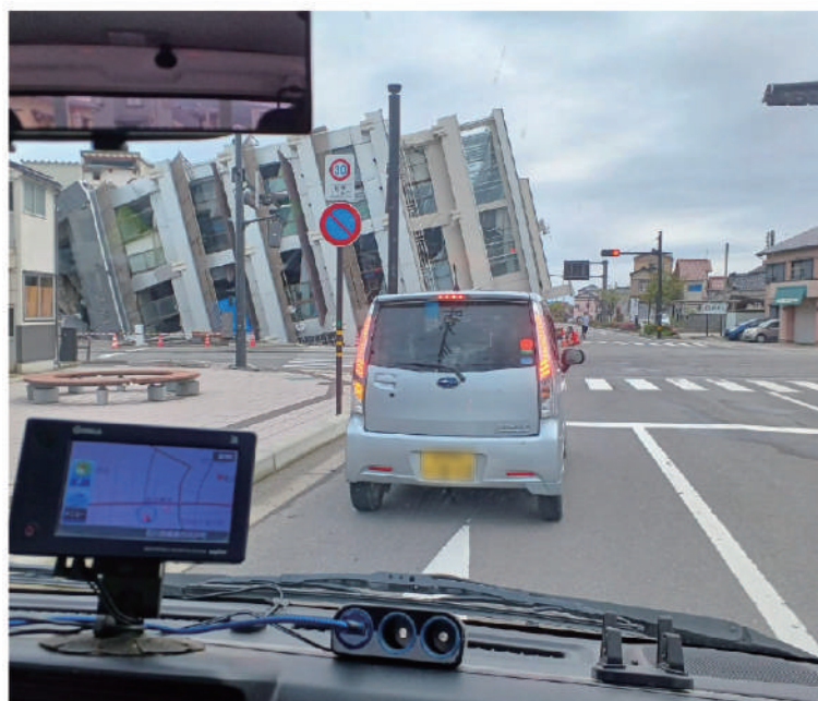
現場へ向かう途中の車内から見える倒壊したビル
