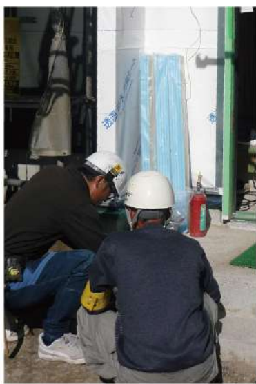
安全な現場か各項目を確認
