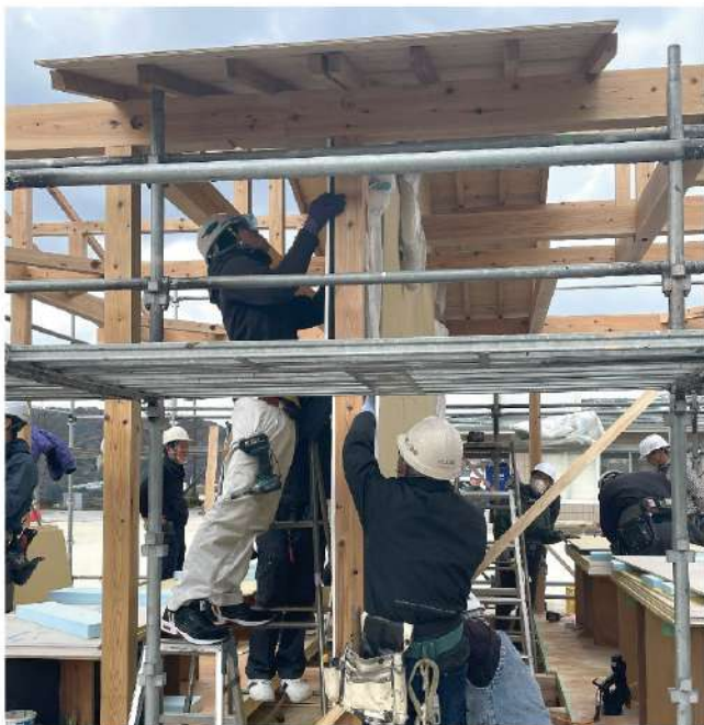
断熱材の上にボードを貼り界壁を仕上げていく
